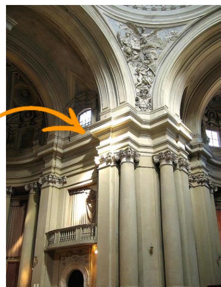
Dettaglio dell'interno della Chiesa dei Santi Luca e Martina, pilastri ionici binati.
